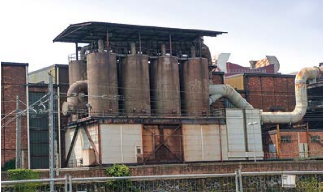
Cornigliano (GE), impianti dismessi dell'Italsider.
